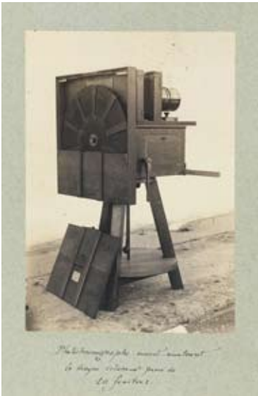
8 ÉTIENNE JULES MAREY (1830-1904) Photochronographe ouvert montrant le disque éclairé percé de 10 fenêtres. Planche n°7 de l'album Station physiologique : travaux exécutés pendant l'année 1886-1887. Tirage sur papier albuminé, 1886-1887. D'après un négatif sur verre au gélatino-bromure d'argent, 1886-1887. © Bibliothèque de l'Hôtel de Ville, Paris/Roger-Viollet
